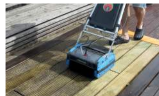
Reinigung der Terrassenoberflächen mittels Bürstmaschine.
